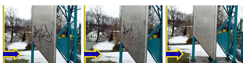
Chemiczne usuwanie graffiti z blachy nierdzewnej, przy użyciu środków AGS 5, AGS 221
