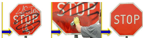
Chemiczne usuwanie graffiti ze znaków drogowych, przy użyciu środków AGS 5, AGS 221
