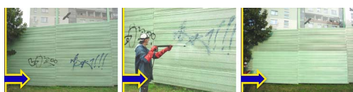
Chemiczne usuwanie graffiti z metalowych ekranów akustycznych, przy użyciu środków AGS 221, AGS 5
